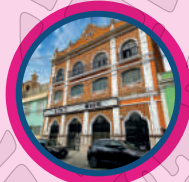
Cine Pardavé (16 Oriente 10) Actualmente se realizan trabajos de intervención en el inmueble
