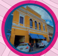
Cine Constantino (6 Poniente 513) Actualmente el inmueble tiene uso comercial, y se encuentra ocupado por una zapatería y un estacionamiento
