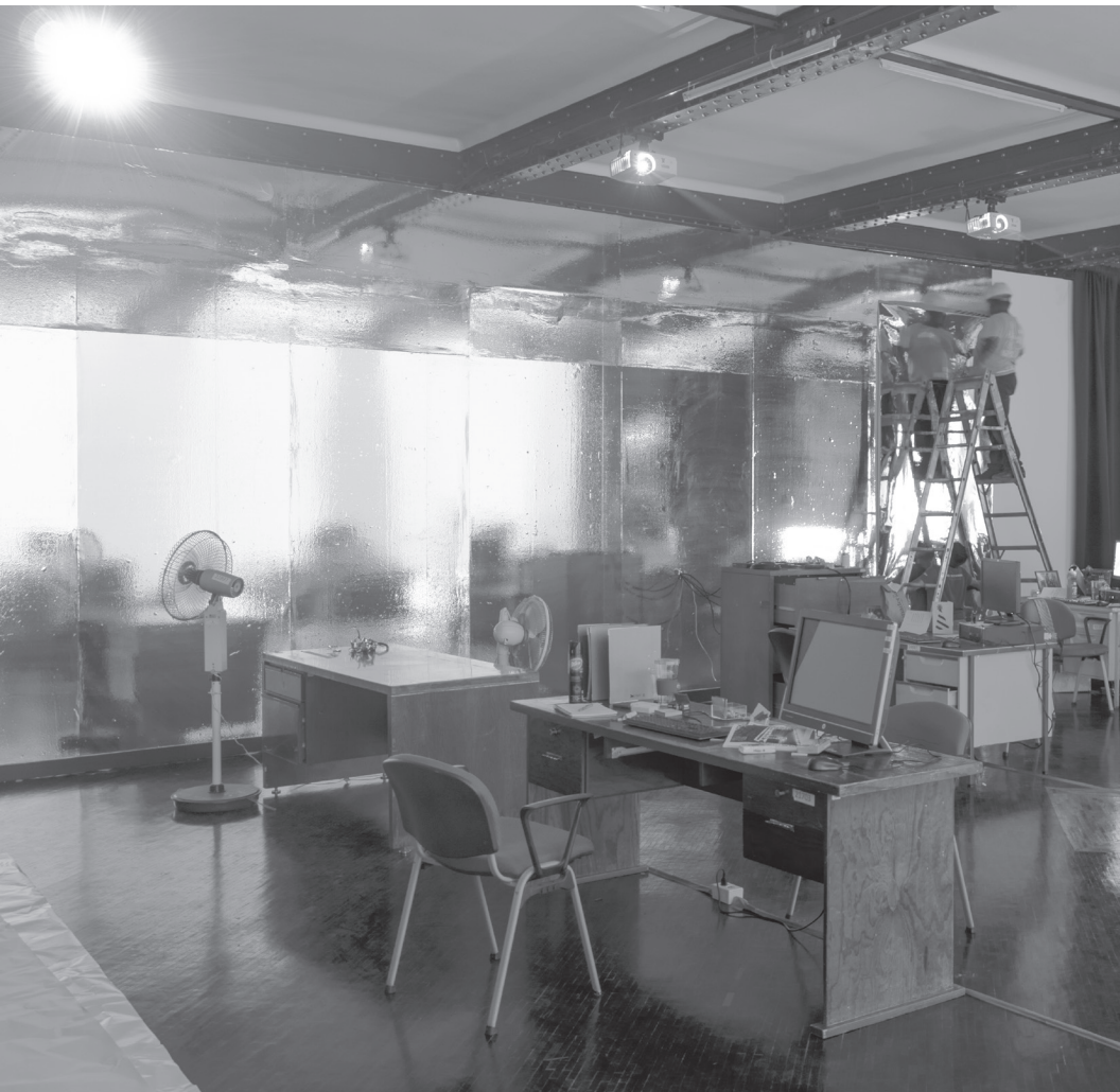
Imagen 6. Instalación de la película mylar durante el montaje.
