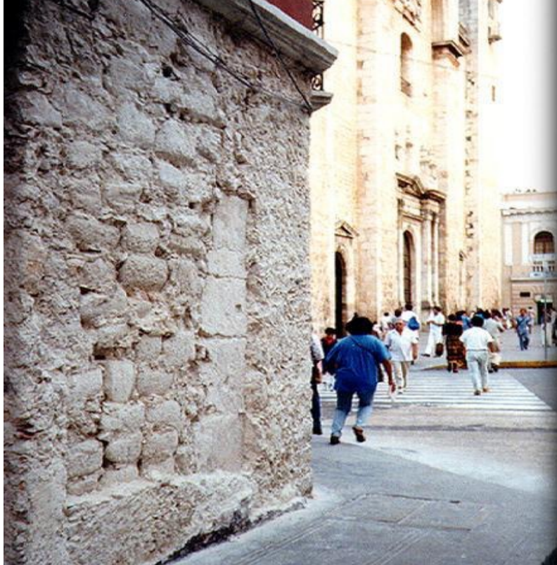
Figura 6. Muro de la Casa Pedz Balam en el que se observa la reutilización de los materiales constructivos de los edificios mayas de T'Hó en las primeras casas coloniales (foto del autor).
