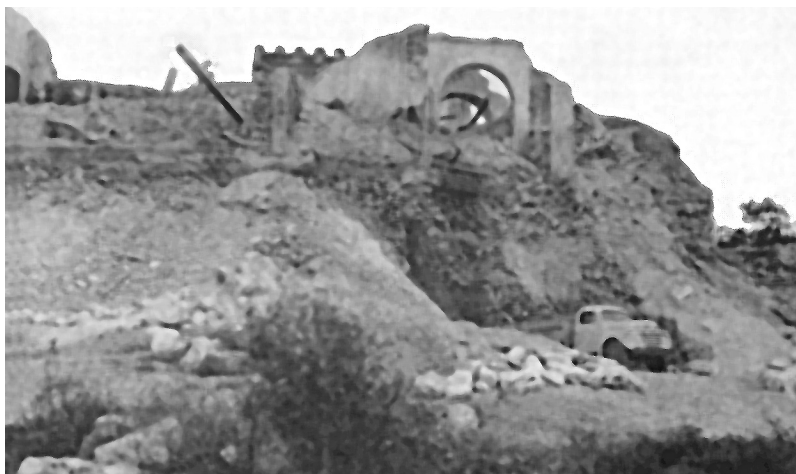
Figura 4. Volquete en el proceso de demolición de la gran plataforma maya donde se encontraban todavía vestigios de la ciudadela de San Benito y del convento de San Francisco (archivo Guerra).
