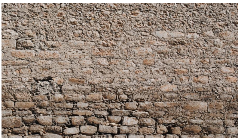
Figura 7. Muro sur del templo de la Tercera Orden donde se observan piedras labradas expolios de la decoración de los edificios de la ciudad maya (foto del autor).
