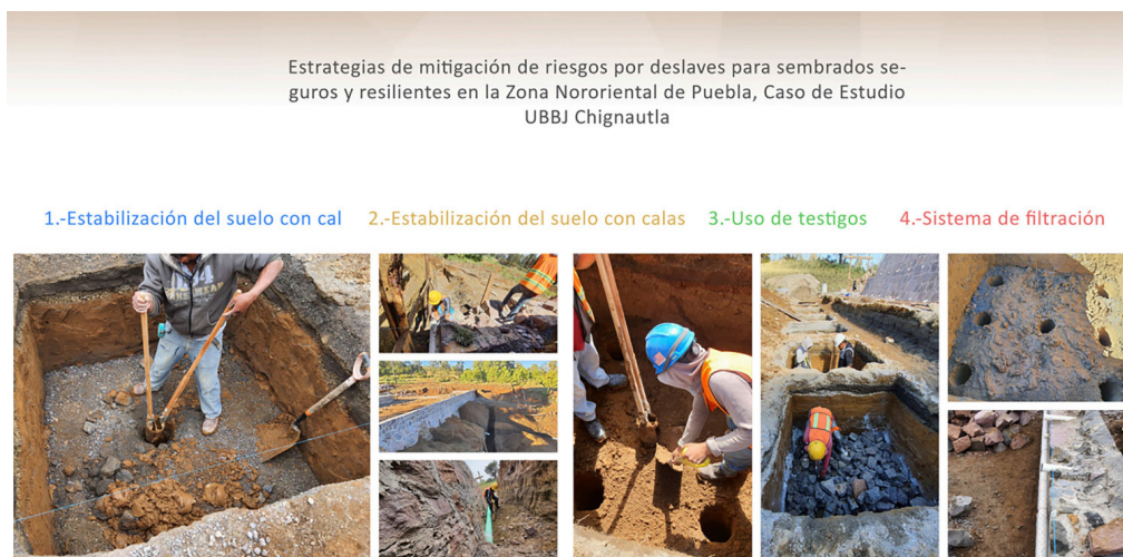
Imagen 1. Estrategias de mitigación de riesgos por deslaves para sembrados seguros y resilientes UBBJG Chignautla. Fuente: Neve, L.
