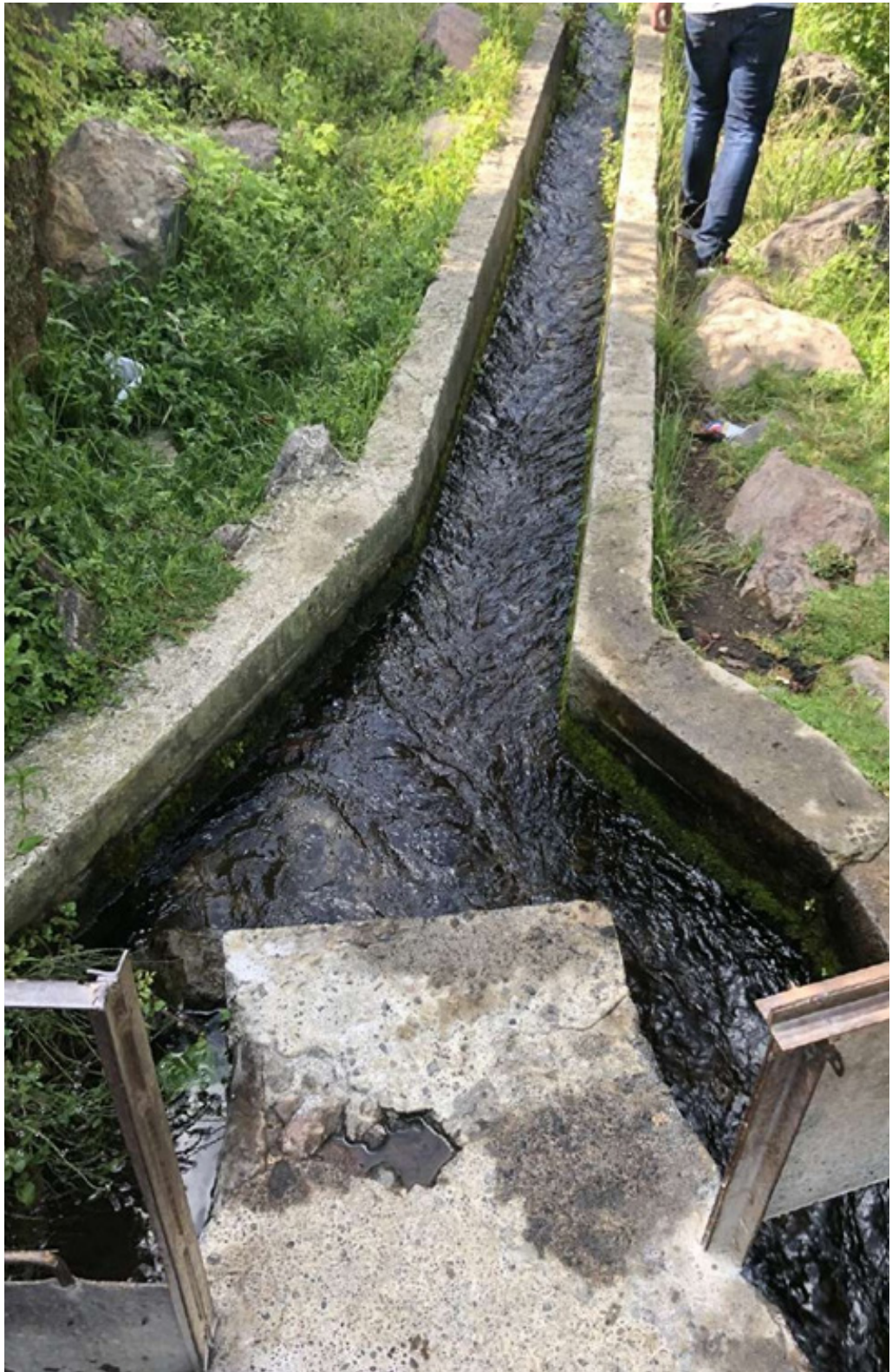
Imagen 3. Bifurcación en la red de acequias que desvían el agua por medio de compuertas que el comisionado se encarga de abrir y cerrar. Foto: Jaspeado, J.L 2019
