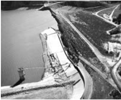
← Figura 4. Daños en la presa Lower Van Norman después del sismo de San Fernando (tomada de The San Fernando, California Earthquake of February 9, 1971 , por U. S. Geological Survey, 1971, United States Government Printing Office).
